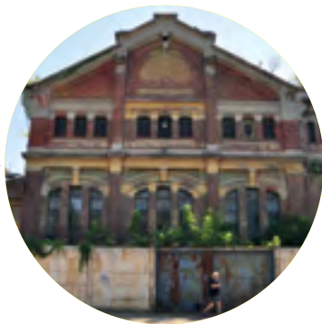
Uzina electrică Filaret
